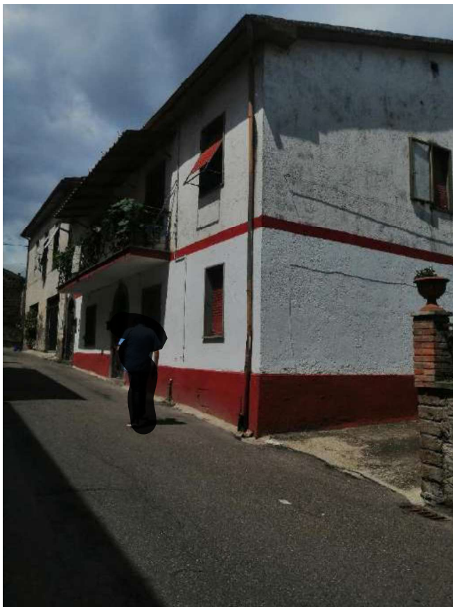
FOTO 1 – VISTA ESTERNA (Lotto 2 e Lotto 3)
